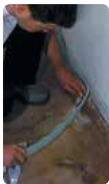
Installazione Uponor bordo perimetrale Minitec
